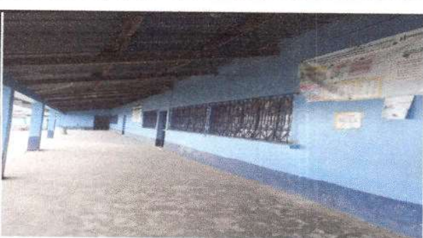
Foto 6: Cambio de balcones
