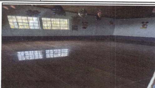
Foto 2: Reparación de piso cerámico
