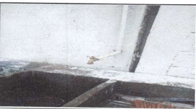
Foto 5: Cambio de chorros
