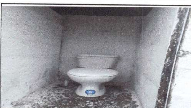
Foto 4: Sustitución de inodoro
