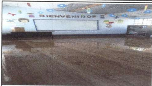
Foto1: Reparación de piso cerámico
